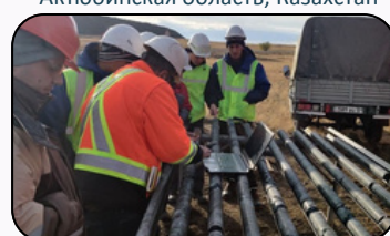
2022 — Геотехнические работы ERG Хромтау, Казахстан
